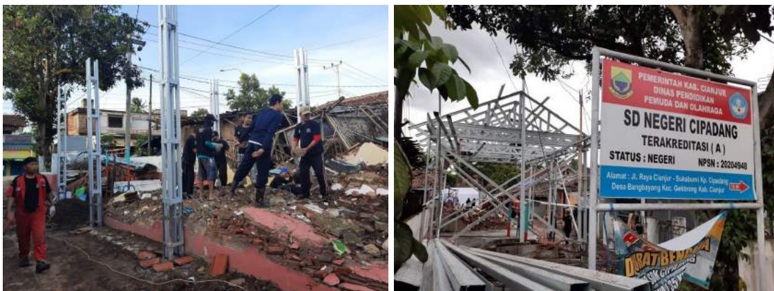
Gambar 24. Proses pembuatan bangunan tahann gempa
