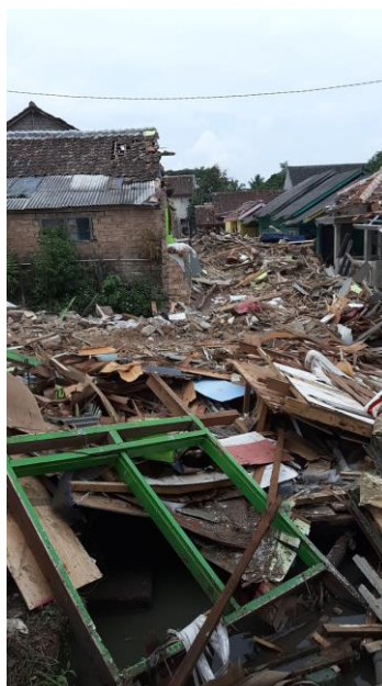
Gambar 2. Runtuhan gempa di Cianjur Sumber: Observasi langsung
