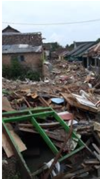
Gambar 2. Runtuhan gempa di Cianjur
